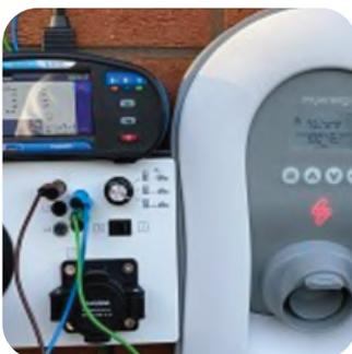
**Schritt 10: Prüfung und Zappi starten**
